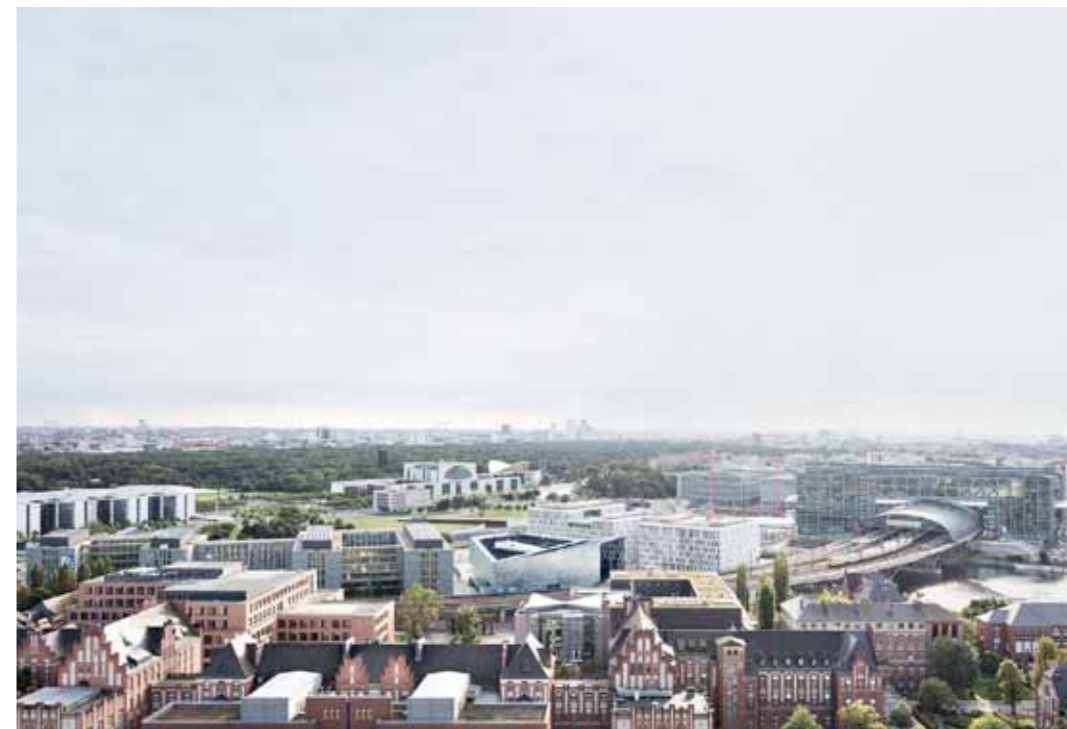
Der Spreebogen mit dem Futurium auf dem letzten freien Grundstück. Im Vordergrund die Charité, rechts der Hauptbahnhof. Zur Spree wie zur Stadtbahn im Norden kragt das Gebäude über den Eingängen weit aus. Lageplan im Maßstab 1:25.000
