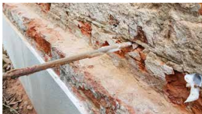
Einbringen der Injektionscreme
