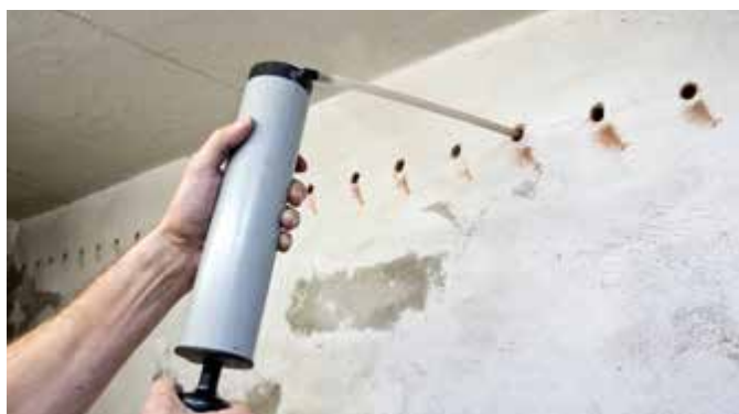
Säubern der Bohrlöcher
