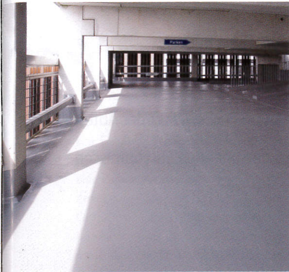
Planeben und gut geschützt gegen Belastungen mit den Remmers-Systemen OS 8 und OS 11b.
