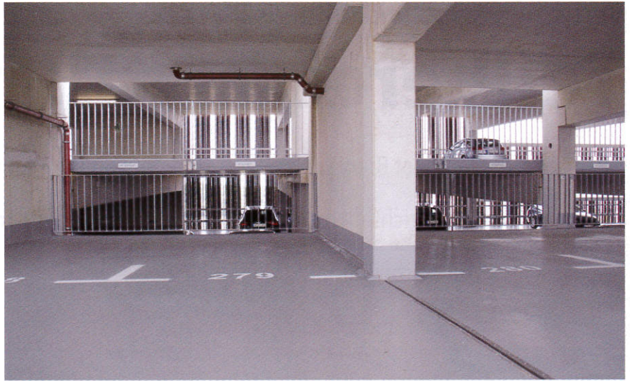
Mit dem Grundier- und Mörtelharz Epoxy ST 100 von Remmers wurden auf den unterirdischen Parkdecks Unebenheiten des Rohbodens ausgeglichen und ein exaktes Gefälle hergestellt. So kann Wasser besser abfließen.
