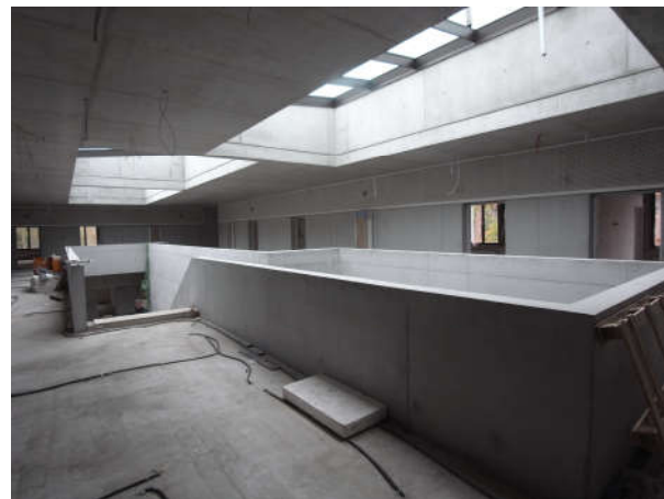
Atrium im Rohbau 2.OG
