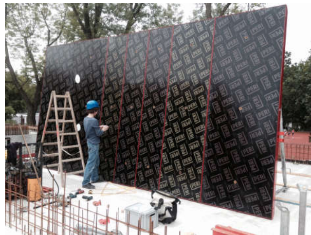
Anbringung der Matrizen als Platzhalter für Intarsien
