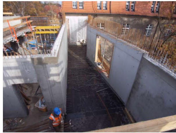
Betonage der Wände mit Fassadenknick
