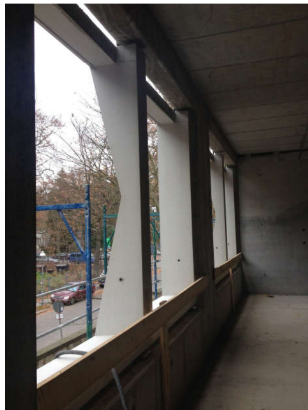
Anbringung der Fertigteile
