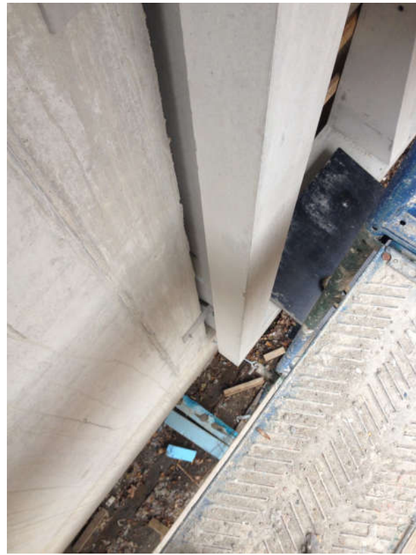
Anbringung der Fertigteile
