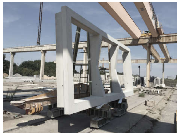
Bemusterung der Fertigteilrahmen
