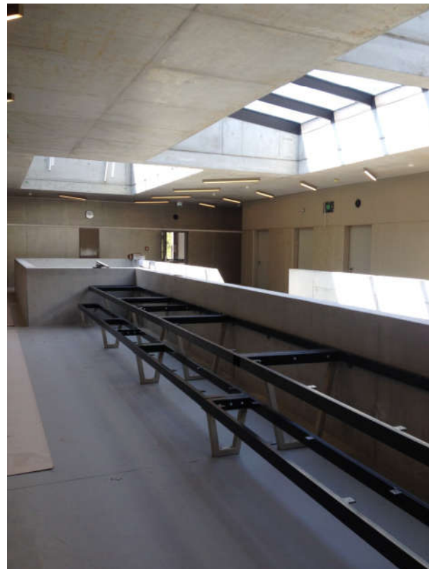
Tischlerarbeiten der Unterkonstruktion des Atriumtisches
