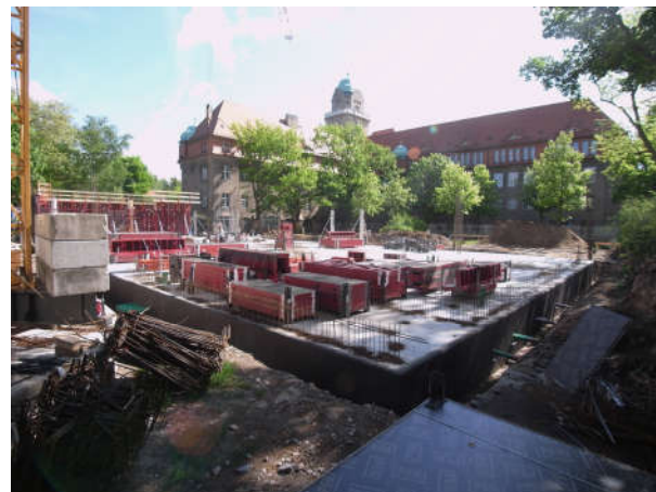
Schalung der ersten Wände
