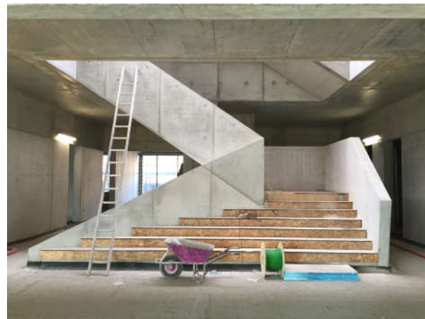
Atrium im Rohbau 0.EG
