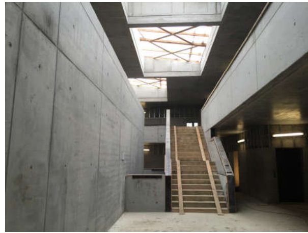
Atrium im Rohbau 1.OG
