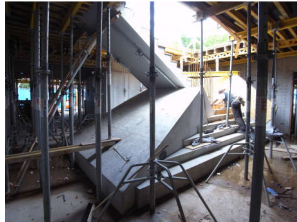
Schutzmaßnahmen der Fertigteilertreppe
